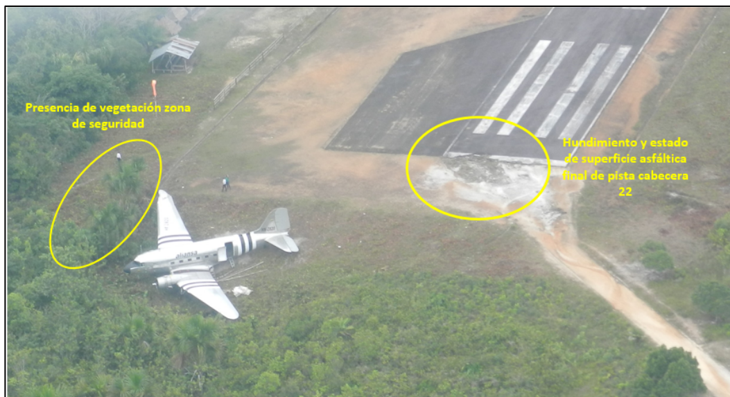
Fotografía No. 14: Zona de seguridad y final cabecera 22
