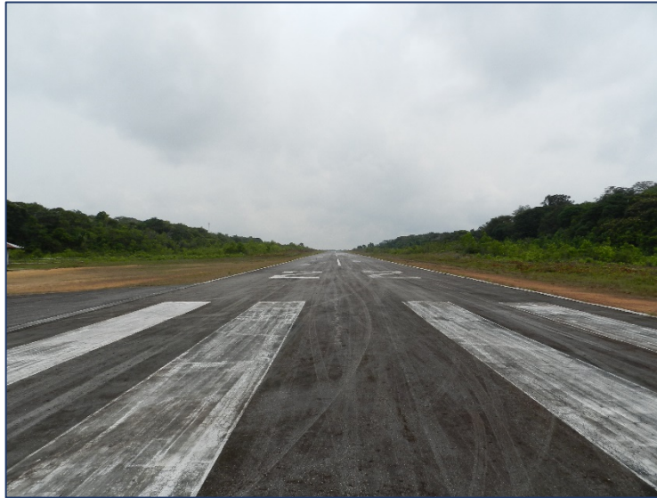
Fotografía No. 11: Condición de la superficie asfáltica pista La Chorrera
